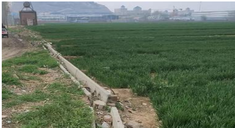
图 1-9 项目区田间基础设施
