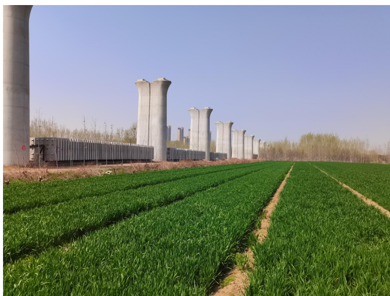
图 1-7 正在建设的济郑高铁（陡沟街道双庙屯村）
